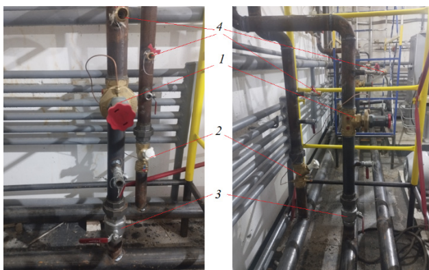
Рис. 5. Внешний вид узла подключения Ст. 1: 1 – регулятор дифференциального давления GIACOMINI R206C DN50 - 2" (R206CY108); 2 – клапан балансировочный GIACOMINI 2" статический со штуцерами для измерения разницы давления (R206BY004); 3 – шаровый кран DN50; 4 – точки отбора давления с установленными кранами под манометр
